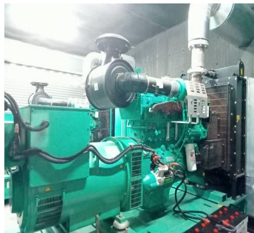
ภาพที่ 57 เครื่องผลิตไฟฟ้าสำรอง
